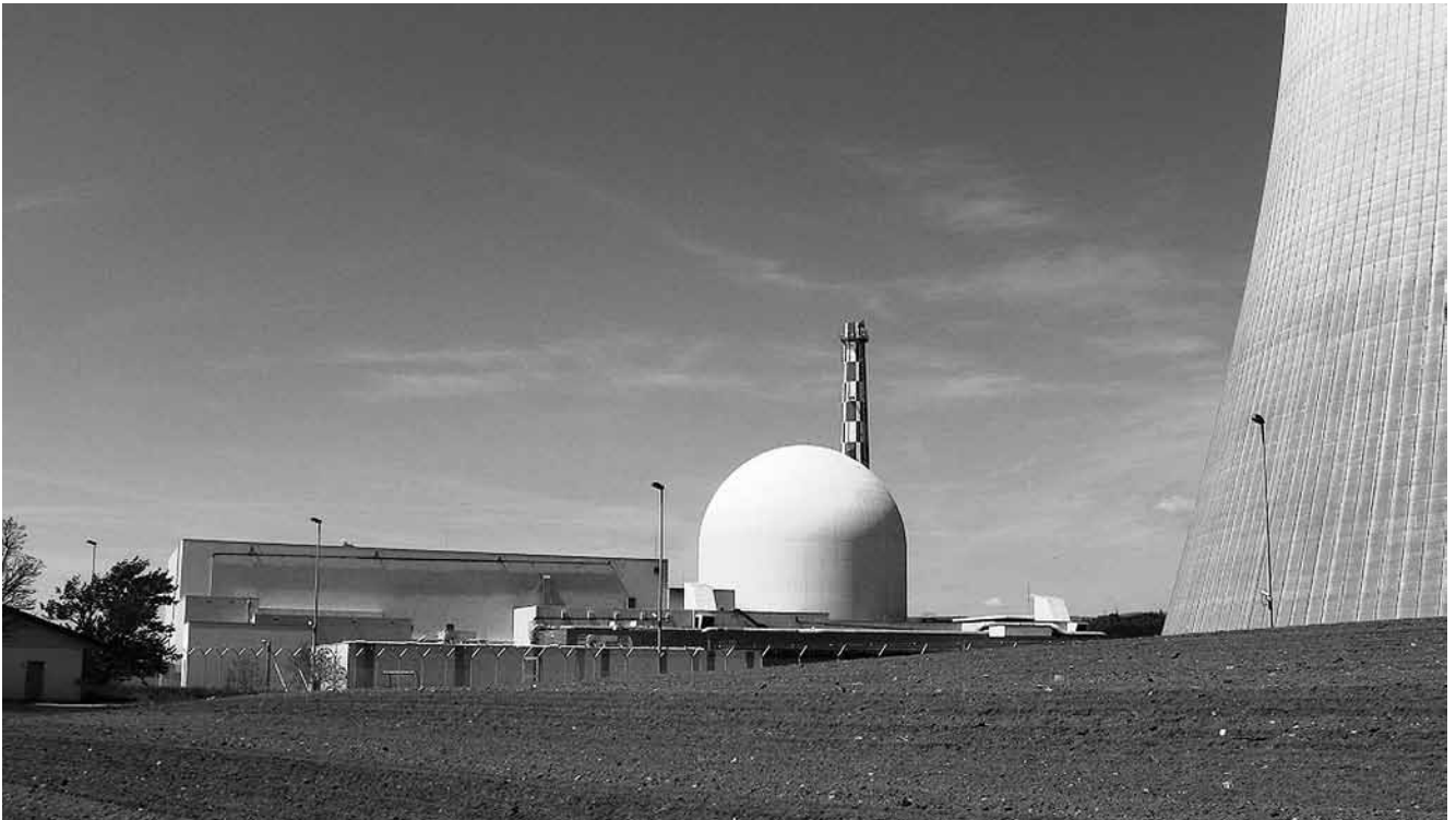
Das Kernkraftwerk Leibstadt ist das jüngste und grösste Atomkraftwerk der Schweiz. Über die Axpo ist auch der Kanton Zürich massgeblich als KKL-Eigentümer engagiert – und exponiert.
