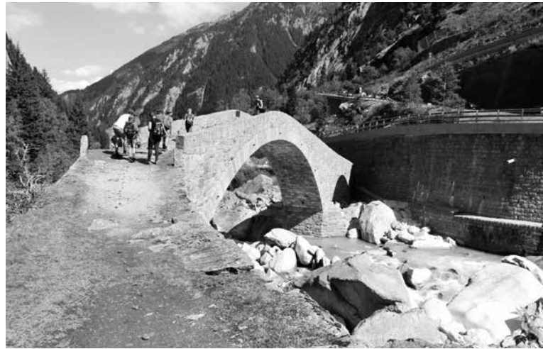
Die Häderlisbrücke (Göschenen) wurde 1649 erstellt.
