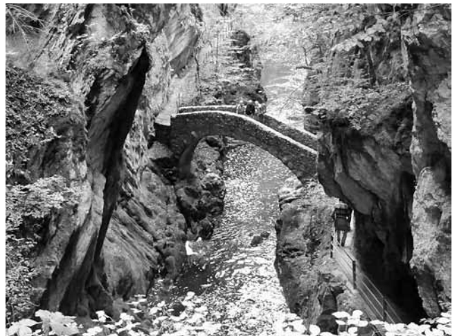
Wunderschöne Steinbogenbrücke in der Areuse-Schlucht.
