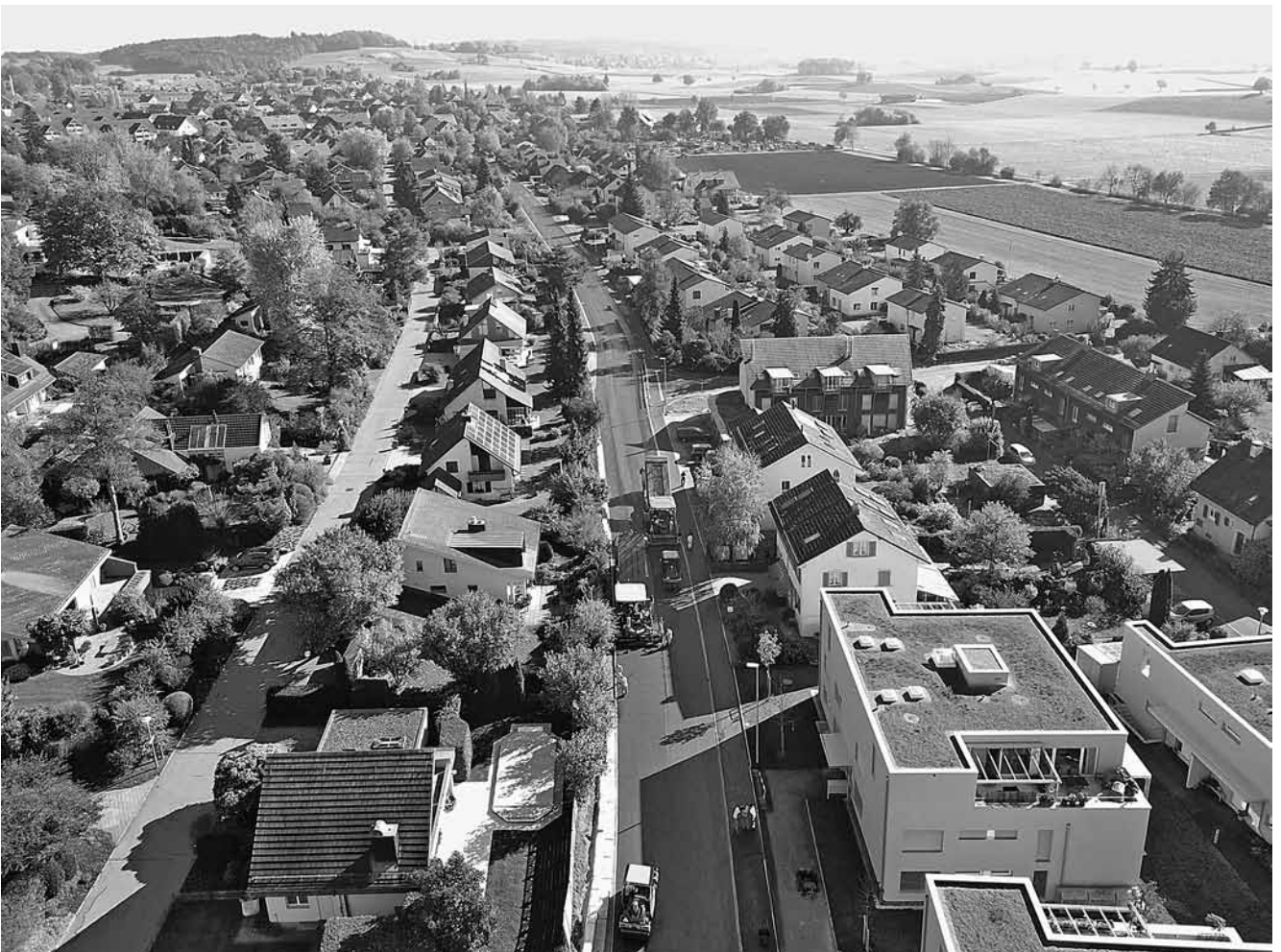
Die neue Stationsstrasse
