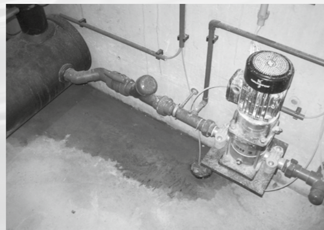
Druckerhöhungspumpe undicht
