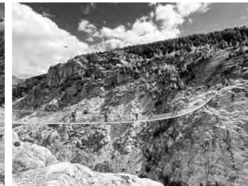
Über die imposante Hängebrücke.
