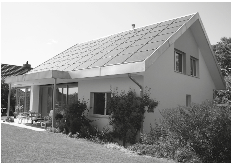
Das im Rechenbeispiel verwendete Haus des Autors verfügt über eine 11-jährige, nach Süden ausgerichtete PV-Anlage mit einer Leistung von 12 kWp.
