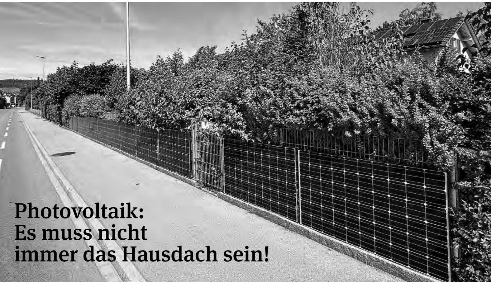
Bild 1: Ein idealer Platz für einen Solarzaun mit Süd-Ausrichtung: die Hettlinger Stationsstrasse (Bild: Dominique Wirz).
