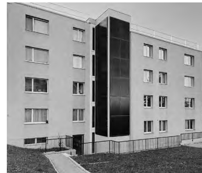
Bild 2: Akzente setzen: Gleichzeitig mit PV-Modulen auf dem Dach wurde hier bei einem MFH in Feuerthalen auch die Fassade des Liftschachts mit PV-Modulen ausgestattet – auch optisch eine Aufwertung (Bild: Robert Büchel).
