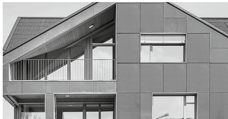
Bild 4: Spezielle PV-Module erlauben es, die ganze Fassade einzukleiden wie hier beim weltweit ersten energieautarken Mehrfamilienhaus in Brütten (Bild: Basler & Hofmann AG)
