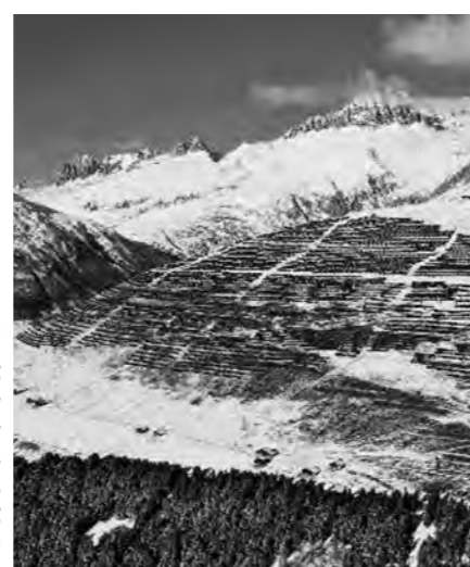
Bild 1: Visualisierung PV-Anlage Sedrun-Solar, energiaalpin.ch, 0,28 km 2 , 18.3 MWp, 27.7 GWh/a, Baubewilligung 29.5.24, Spatenstich 16.8.24.
